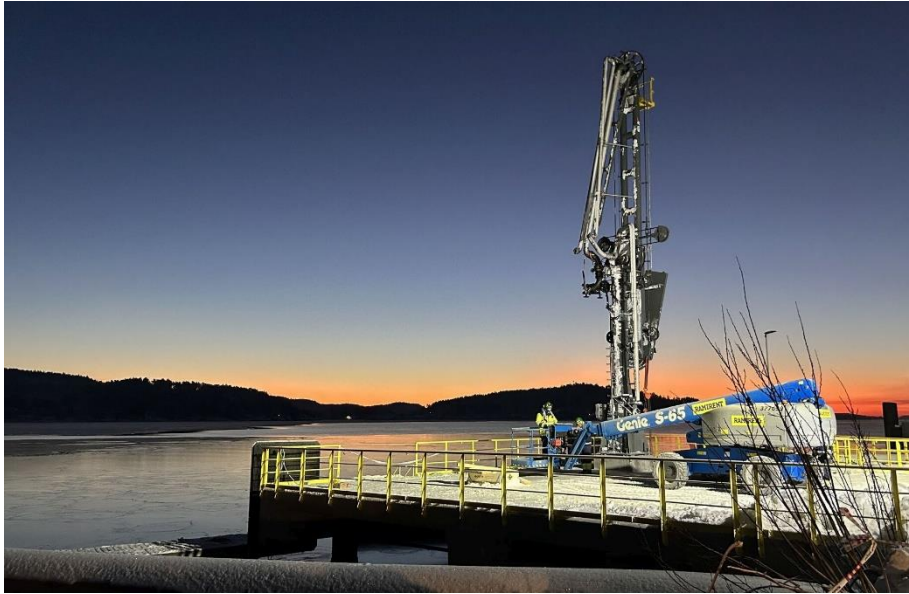
Figur 38 Lastarm för LCO 2 under installation i Brevik, Norge. (Bild: Euromekanik)
