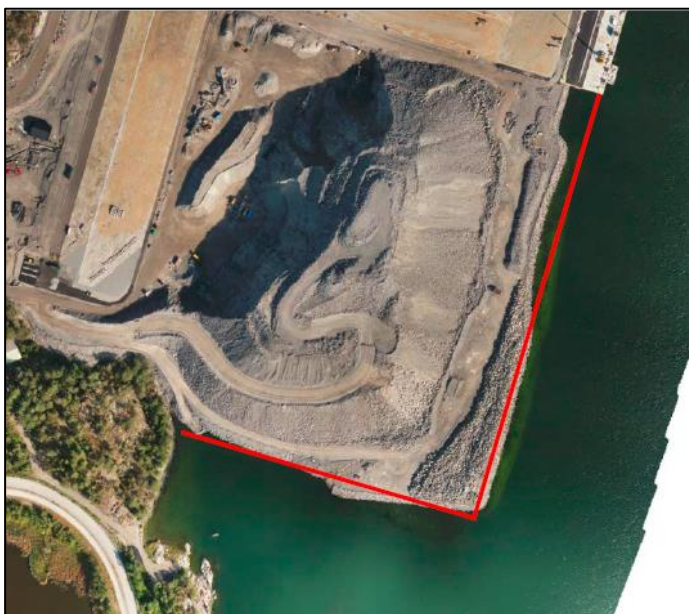
Figur 5 Arbeten i södra delen av hamnen, utbyggnad av kaj 1-2 och inspontning av södra slânten.
