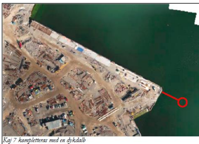
Figur 3 Arbeten i norra delen av hamnen, förlängning av kaj 7.
