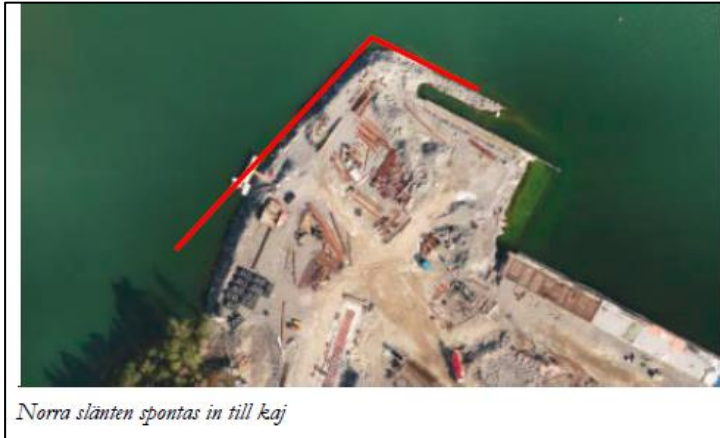
Figur 4 Arbeten i norra delen av hamnen, inspontning av norra slânten.
