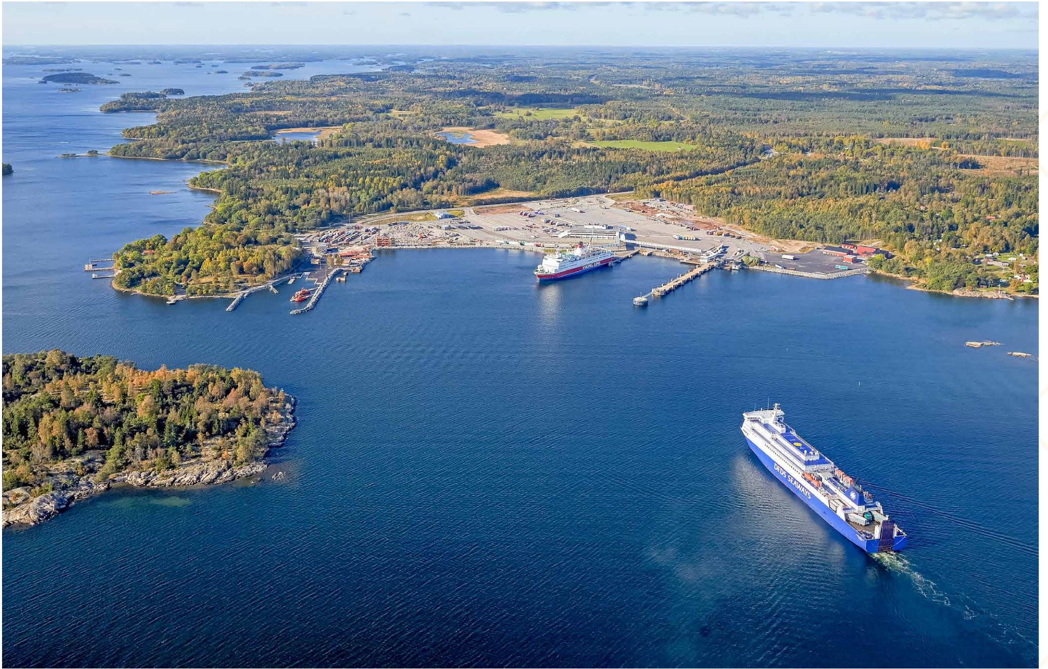
Sjöfartsverkets lotshamn efter ombyggnad, oktober 2014 | Den nya lotshamnen med sina nya vägbrytare har flyttats längre från färjelägena för att ge plats för den ännu inte byggda piren. I förgrunden ses även ön Kapellskäret. Utanför ön har det mudrats för att få en bättre insegling till hamnen.
